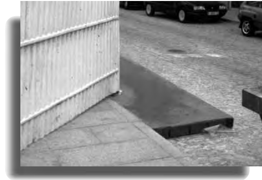
Detalle de ejecución de una acera provisional con lámina de polietileno, base de ladrillo y acabado de mortero.
