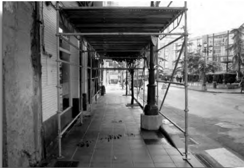
Andamio tubular metálico dejando libre todo el ancho de la calle y con un diseño sin riesgos.
