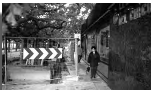
Trabajo por franjas. Cuando se ejecute la franja próxima a la fachada se utilizarán las pasarelas de peatones.
