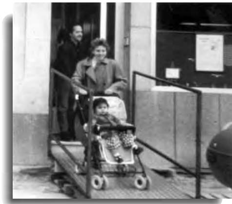
Pasarela de peatones utilizada durante los trabajos de rehabilitación de una calle.
