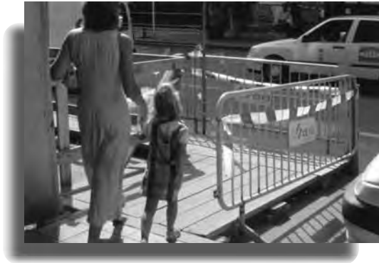
Acera provisional ejecutada con tabloncillos de madera.
