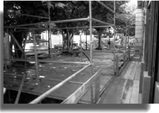
Detalle del pasillo de madera protegido con barandillas.
