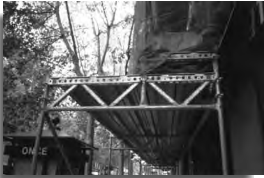
Cercha o viga de transición entre el nivel de la calle y el resto de los niveles.
