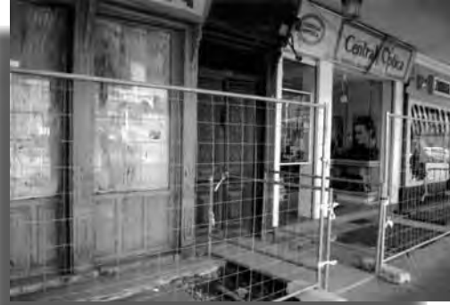
Vista de una mejor solución con pasarela y vallas de malla electrosoldada en lugar de cintas protegiendo la zona de trabajos.
