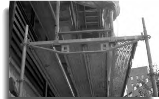
Otro ejemplo de viga en andamio multidireccional.
