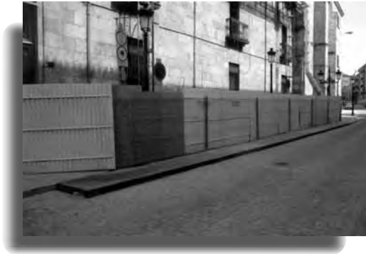
Suplemento de acera en la zona de trabajos.
