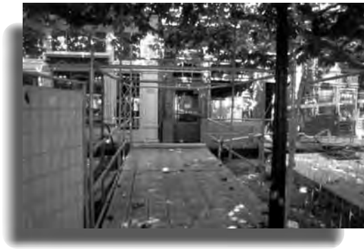
Una gran plataforma salva la zona de trabajos, desarrollándose un pasillo de tablonos de madera para dar acceso a portales y locales comerciales.
