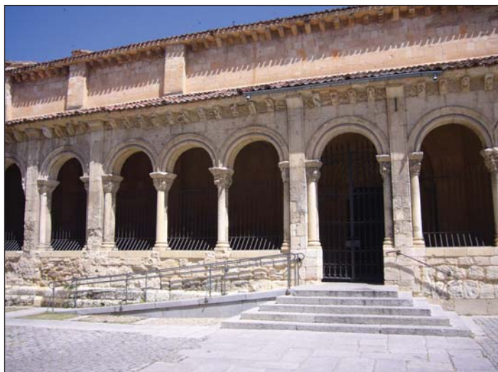
Iglesia de San Millán (Segovia), rampa y escaleras de acceso (Fotografía: J.A. Juncà Ubierna)
